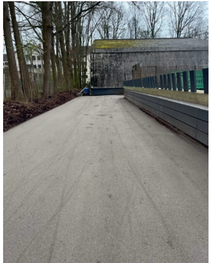
Die neue Zuwegung zur Tennishalle.
